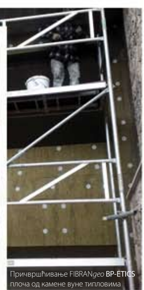
Термоизолација фасадног зида у систему контактне фасаде са FIBRANxps ETICS и са FIBRANgeo BP-ETICS
