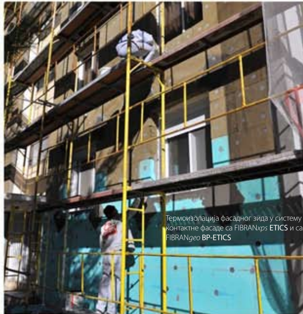
Причвршћивање FIBRANgeo BP-ETICS плоча од камене вуне типловима
