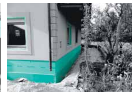
Неутралисање топлотних мостова на шпалетнама и термоизолација сокле плочама FIBRANxps ETICS
