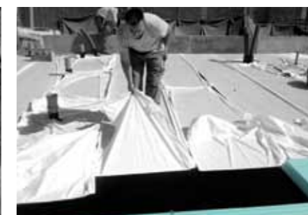
Поступно уклањамо заштитну фолију обострано самолепљиве хидроизолације FIBRANhydro SEISMIC T-1,8 sk/sk.
