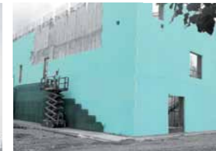
FIBRANxps MAESTRO као термоизолација у сендвич зиду; фаза извођења завршног слоја фасаде од белог бетона
