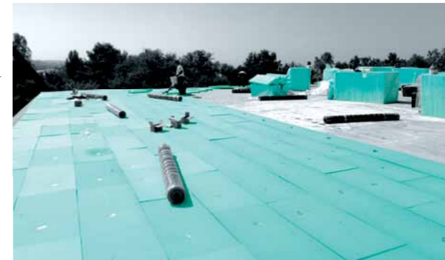
Увећање нагиба кровних равни постојећег равног крова FIBRANxps INCLINE плочама уз истовремену енергетску санацију
