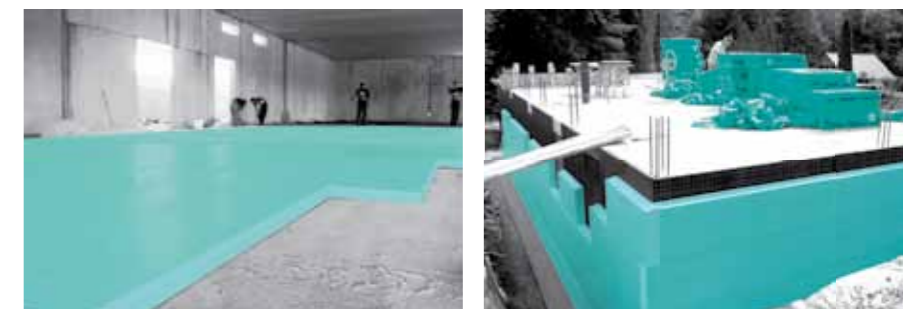
Термоизолација пода у складишту FIBRANxps 300-L плочама
