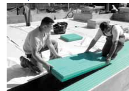
Плоче FIBRANxps SEISMIC полагамо пажљиво и прецизно на лепљиву површину хидроизолације
