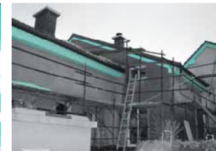
Кровни венци изведени плочама FIBRANxps ETICS. Дебљина зависи од распона конструкције
