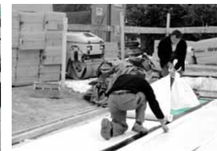
На прецизно положен први слој термоизолације FIBRANxps одговарајуће дебљине и чврстоће, лепимо обострано самолепљиву хидроизолацију FIBRANhydro SEISMIC T-1,8sk/sk.
