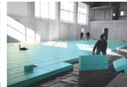
Уградња термоизолације FIBRANxps 500-L испод подне плоче више наменског објекта
