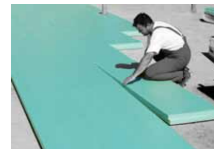
Пре уградње бетона и првог слоја термоизолације FIBRANxps (400-L, 500-L, 700-L) посебну пажњу треба обратити на инсталације ( www.fibran.com )
