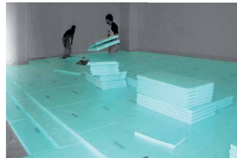
Термоизолационе плоче FIBRANxps 300-I са равном ивицом, „без фалца“, намењене су употреби у вишеслојним склоповима.
